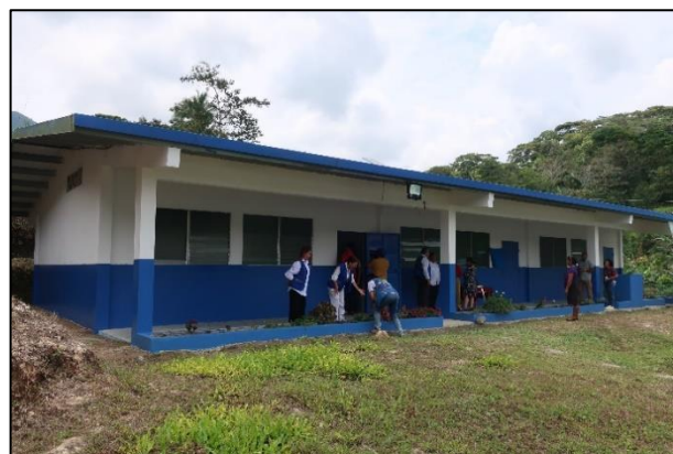
Las Tres Aulas Nuevas
