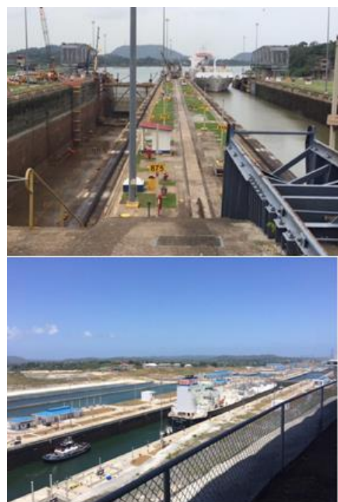
ミラフローレス閘門（第一及び第二閘門）船舶通航（上）左レーンは定期修繕で水抜き済 アグア・クララ閘門（第三閘門）船舶通航（下）レーン左手：節水槽
