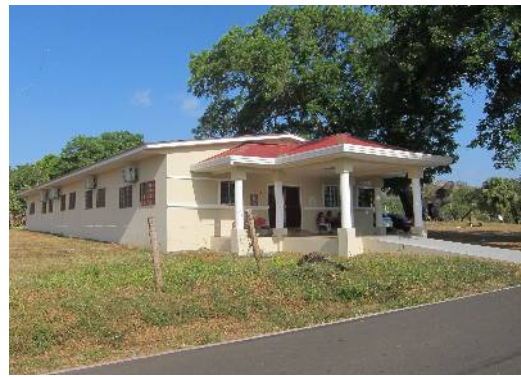
新しく建設されたセンター
