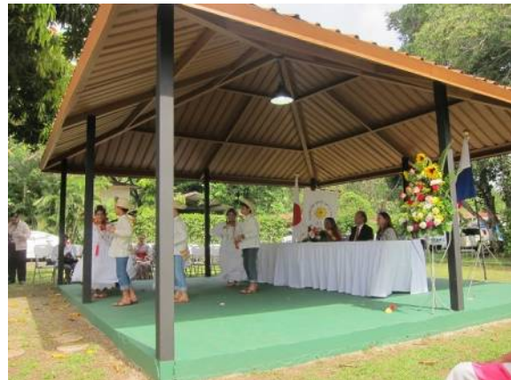
建設された野外実習室
