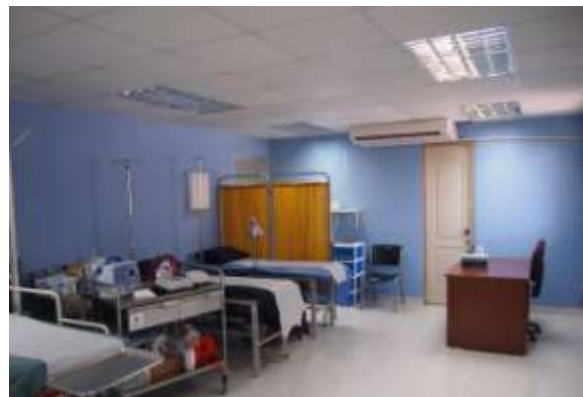
改修された診察室
